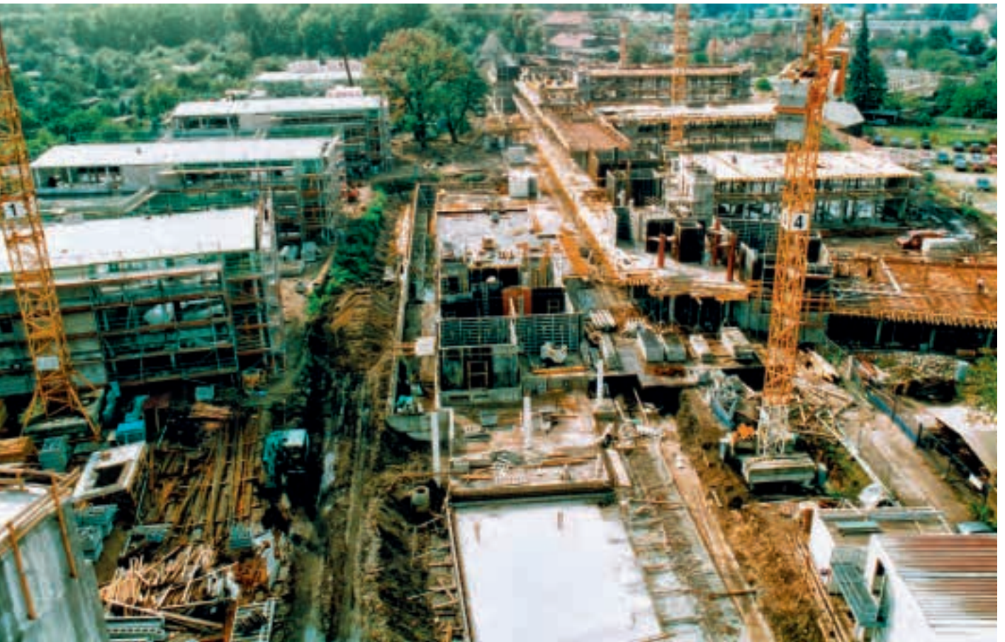
Hier entsteht das Kreishaus in Luckenwalde.
